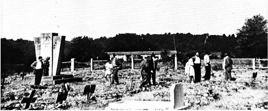
Vista general del Campo de Vermet poco antes de ser derribado (1945)
